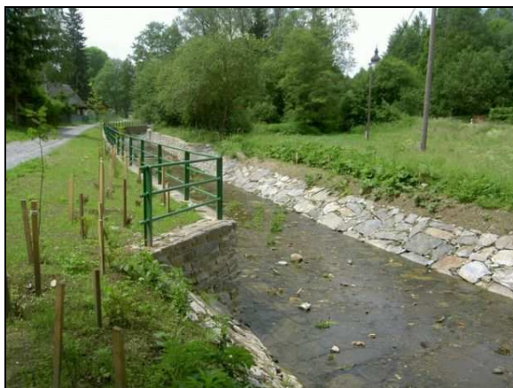
Foto 16. Upravené koryto Opavice v Heřmanovicích (zdroj: http://www.lesy.cz/ ).
