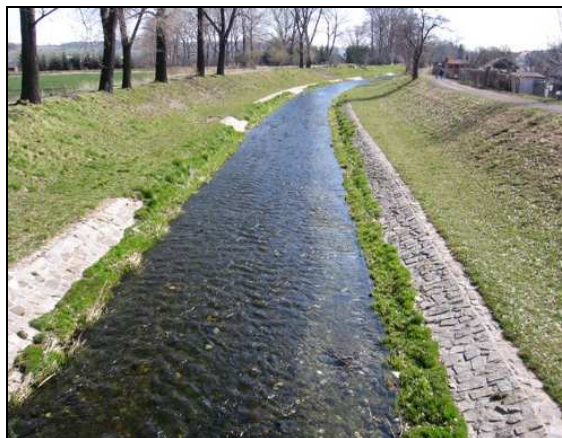
Foto 17. Upravené koryto Opavice v Krnově.
